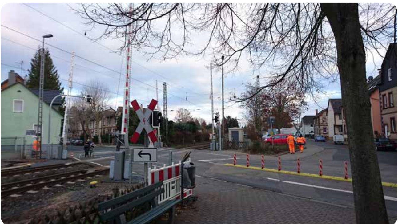
Abb. 22: Bahnübergang Rochusstraße; Quelle: ProjektStadt
